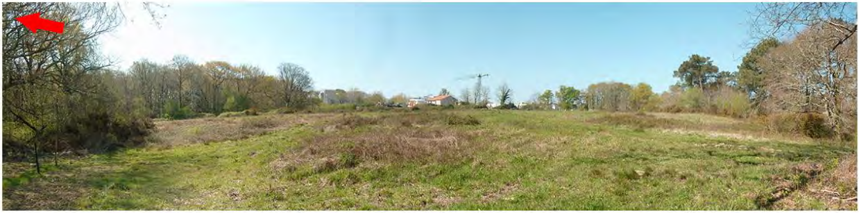
vue sur la prairie, les boisements périphériques et en arrière plan les bâtiments en cours de construction
