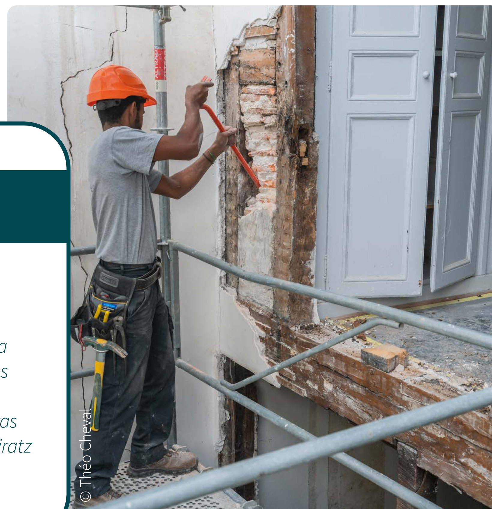
Curetatge de l'immòble 37 arrua d'Espanha
