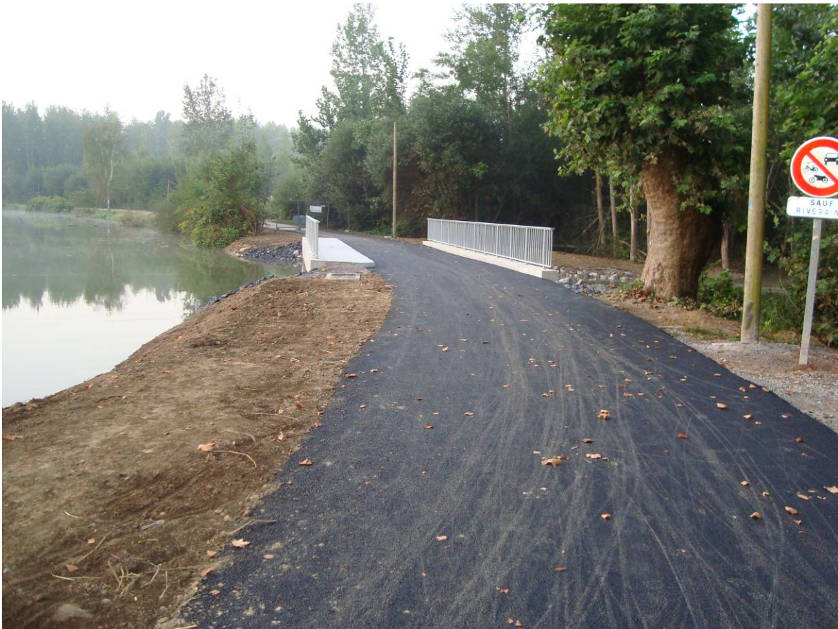
(Le pont après les travaux)
