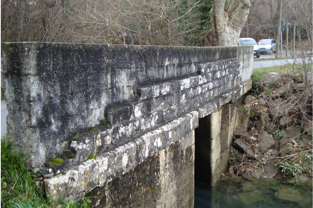
(Le pont avant les travaux)
