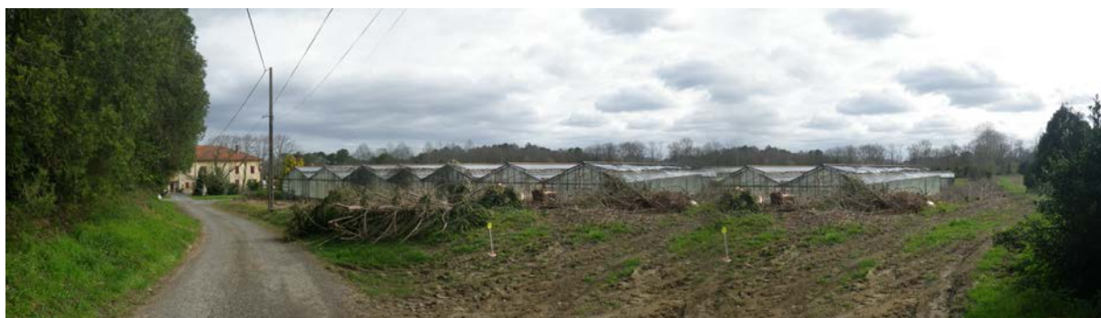
Le site de Bellecave, avant les travaux de rénovation
