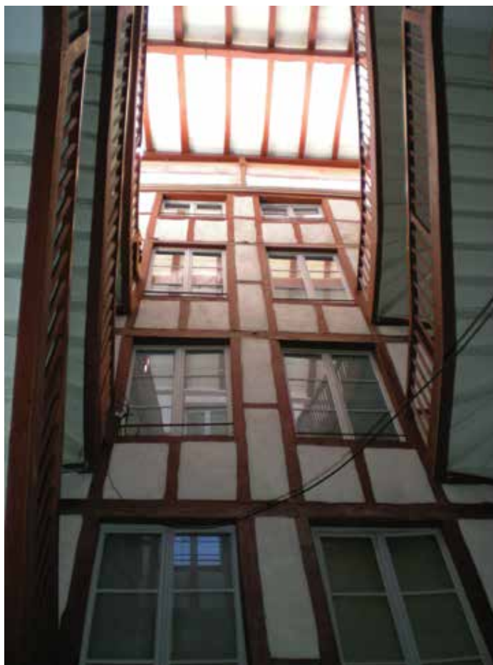
Cage d'escalier de la rue des Faures.
