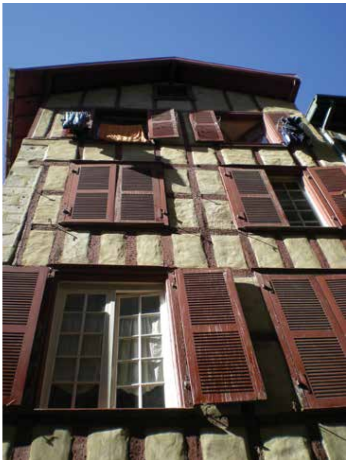
Immeuble de la rue des Faures.
