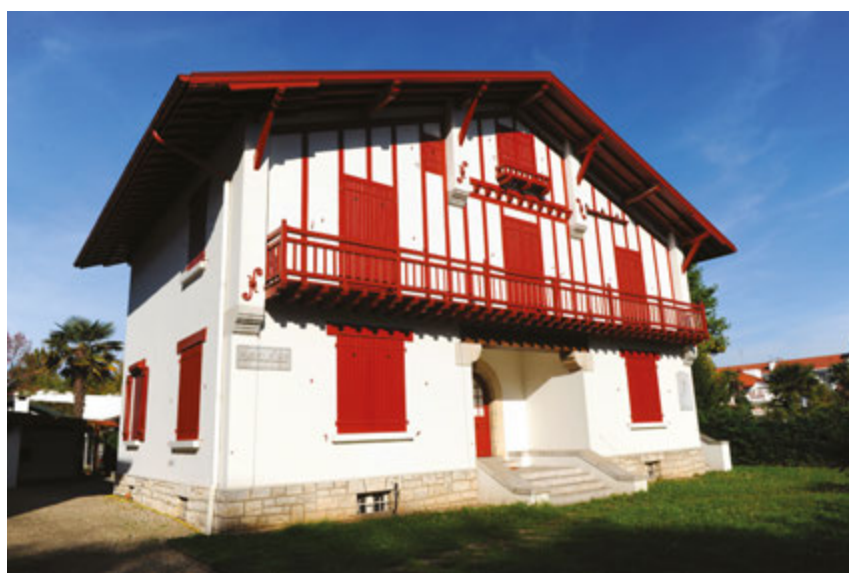
La villa Madeleine, sur les allées Paulmy, réalisée en 1924 par les architectes Jean et Joseph Soupre. © Z-Studio
