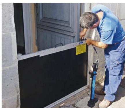
Pour lutter contre les inondations, la Ville subventionne l'acquisition de batardeaux, aussi appelés portes anti-inondation, à destination des habitants et des commerçants susceptibles d'être concernés en bord de Nive et d'Adour. Ces dispositifs provisoires, amovibles obstruent une ouverture afin d'empêcher l'eau de rentrer. Efficaces et rapides à installer, ils permettent de lutter efficacement contre les crues. La subvention représente 50 % TTC de la dépense,
