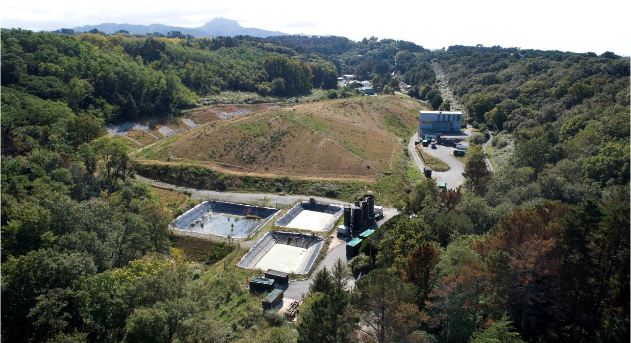
Site de Bittola après réhabilitation
