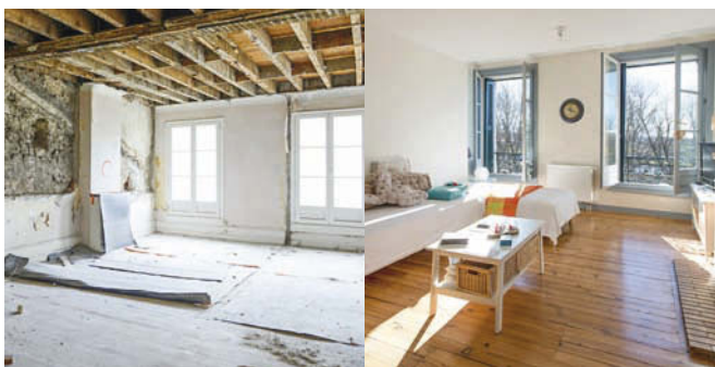
Logement de la rue Vieille-Boucherie avant et après sa rénovation
