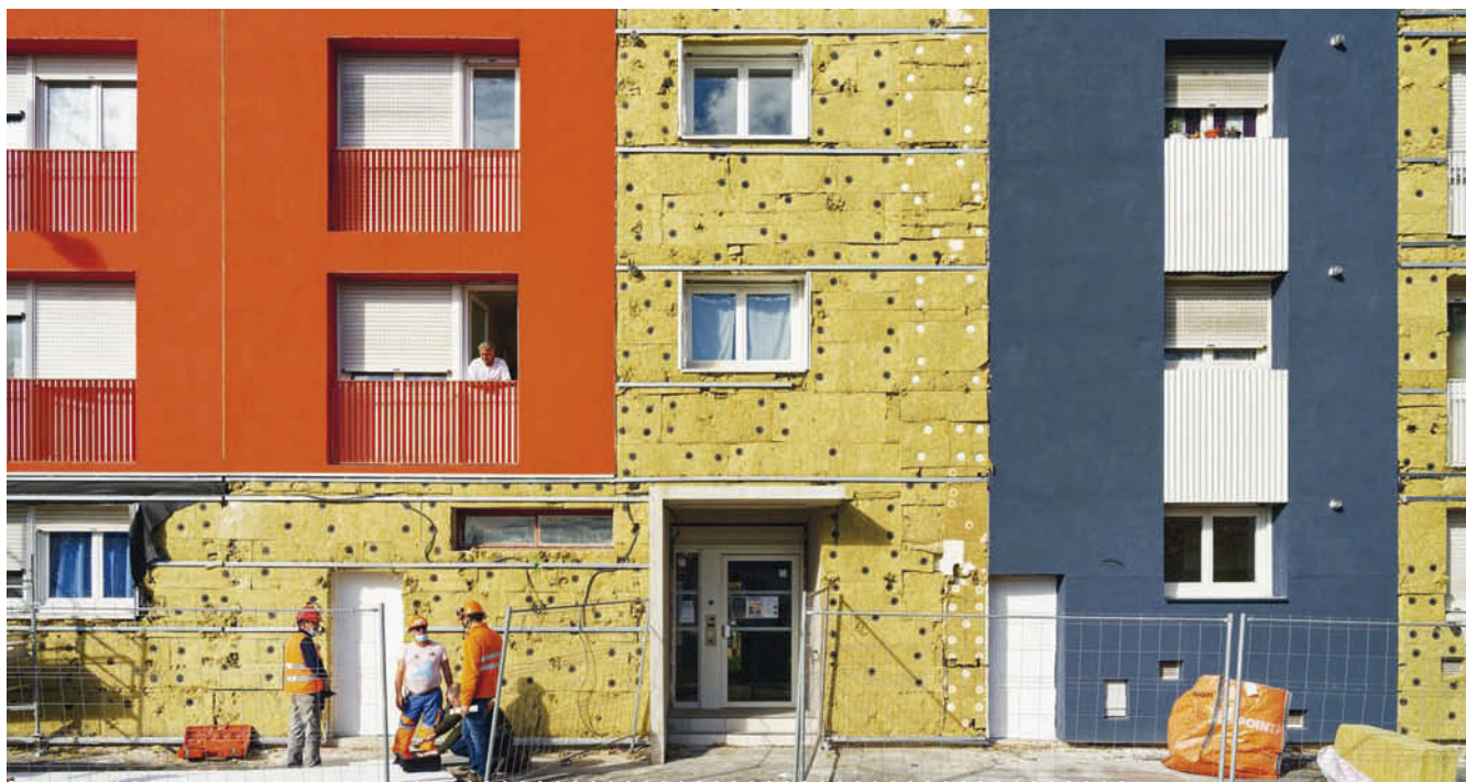
La résidence Balichon a bénéficié de travaux de rénovation intérieure et extérieure et d'amélioration du cadre de vie
