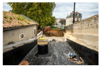
**2/ Les maçonneries extérieures >** les souches qui poussaient dans la maçonnerie ont été extraites. Les pierres les plus altérées ont été remplacées. Le couvrement des murs a été repris et les parements ont fait l'objet d'un rejointoiement et d'un nettoyage complet.
