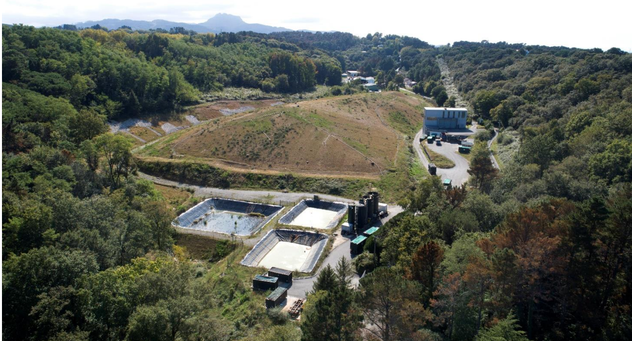
Site de Bittola après réhabilitation
